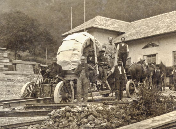
Anlieferung des Generators mit einem Sechsspänner, 1926
